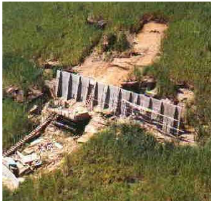
Figura 3.17 - Muro de concreto armado com contrafortes chumbados na rocha (Foto GeoRio)
