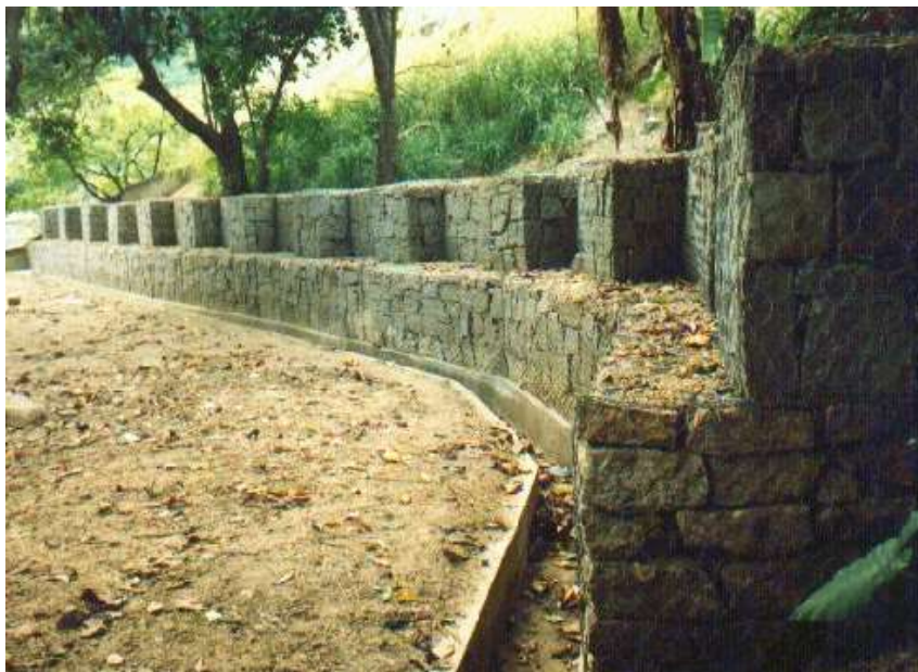
Figura 3.23 - Muro em gabiões (Foto GeoRio)
