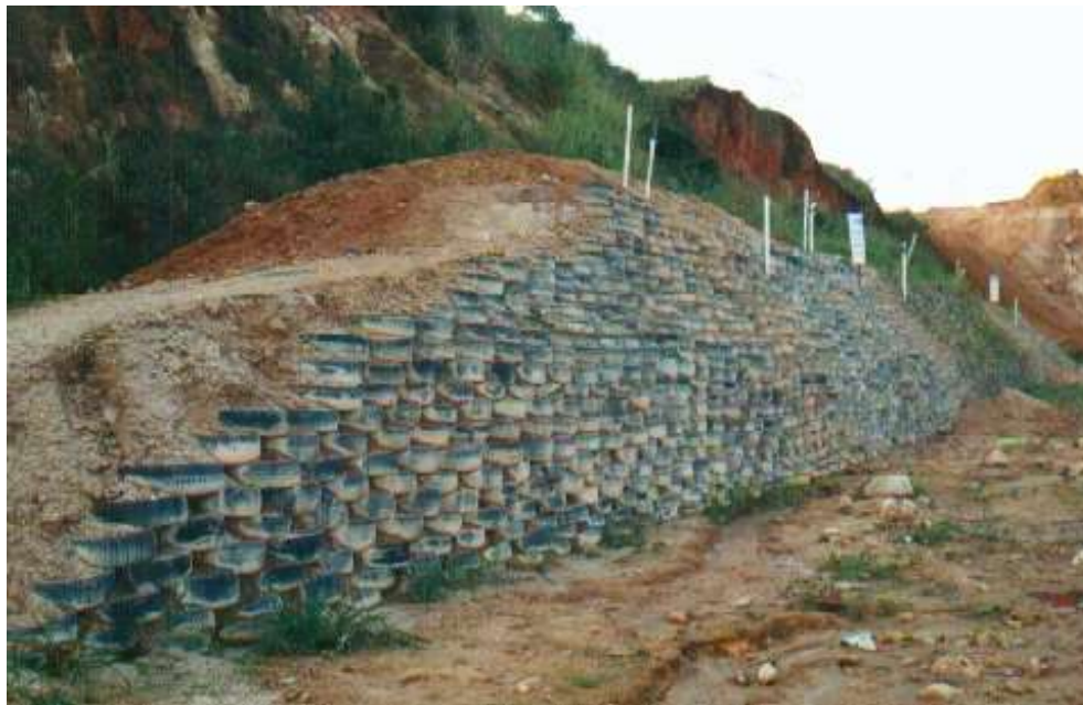
Figura 3.25 - Muro de solo-pneus (Foto GeoRio)
