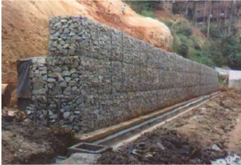
Figura 3.22 - Execução de muro em gabiões (Foto GeoRio)
