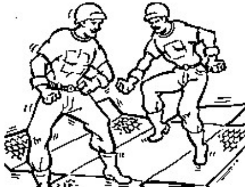
Figura 0.1 - Abertura dos painéis e remoção de irregularidades
