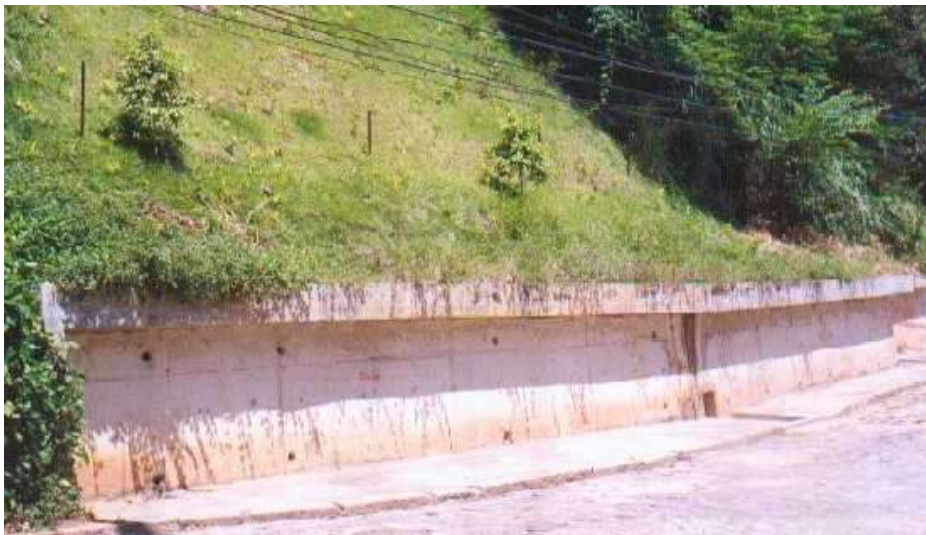
Figura 3.15 - Muro de concreto armado (Foto GeoRio)
