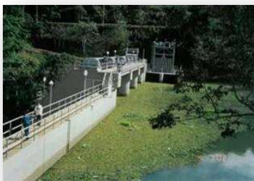
Areal Dam 30 MW
