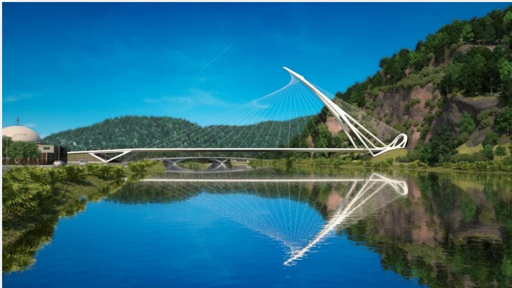
**Descrição:** A Terratek projetou as fundações da Ponte Metro Barra da linha 4, em que o escritório do famoso arquiteto Santiago Calatrava fez o projeto arquitetônico e estrutural. As fundações consistiram em estacas escavadas de 1.2 m de diâmetro pinadas na rocha gneiss.
