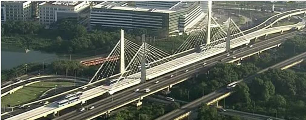
**Descrição:** A Ponte Estaiada Ayrton Senna, construída na Barra da Tijuca para o projeto BRT, tem 200 m de comprimento. As fundações consistem em estacas escavadas de 2 m de diâmetro através de solos moles, saprolíticos e rocha gneiss. As estacas foram pinadas em rocha com pinos executados com estacas raiz de 500 mm de diâmetro e até 8 m de comprimento.
