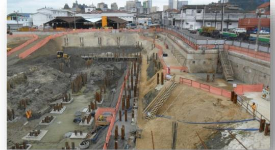
**Descrição:** Terratek projetou a contenção de uma escavação com parede diafragma de 400 mm e 25 m de profundidade para uma escavação de 8 m em areia e argila mole de Santos com ancoragens provisórias. O terreno consta de uma camada de areia fofa seguida de 8 m de argila mole.
