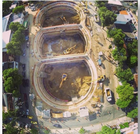
A Terratek projetou vigas internas de suporte em vários níveis e tratamento com colunas de jet grouting na região dos encontros entre círculos, de forma a permitir a concretagem desses nós com concreto moldado in loco.
