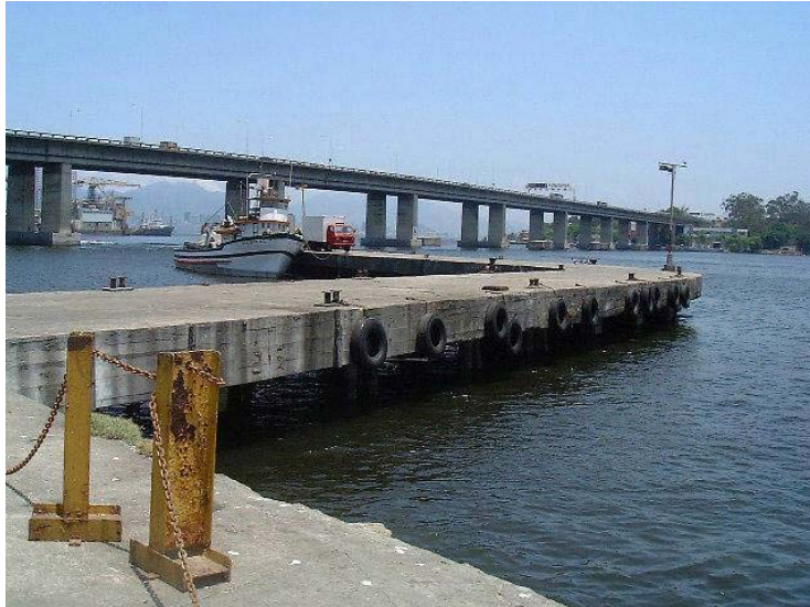
Figura 7 Ponte de acesso e cais, Niterói, Rio de Janeiro
